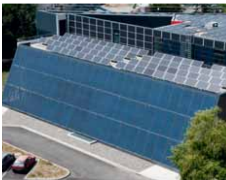
Vue aérienne du bâtiment ADREAM au LAAS ©Crédit photo : CNRS Photothèque : FRESILLON Cyril
