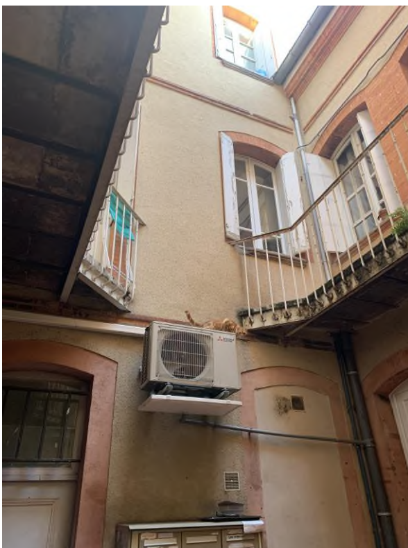
Photo du bâtiment existant depuis le patio
