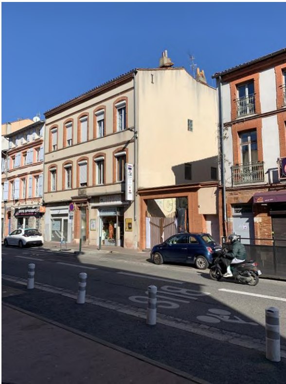
Photo du bâtiment existant sur la Grande rue Saint Michel
