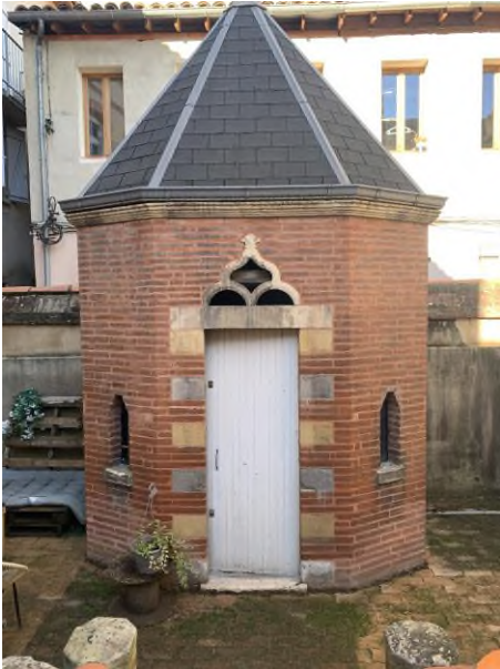
Photo existante de la tourelle
