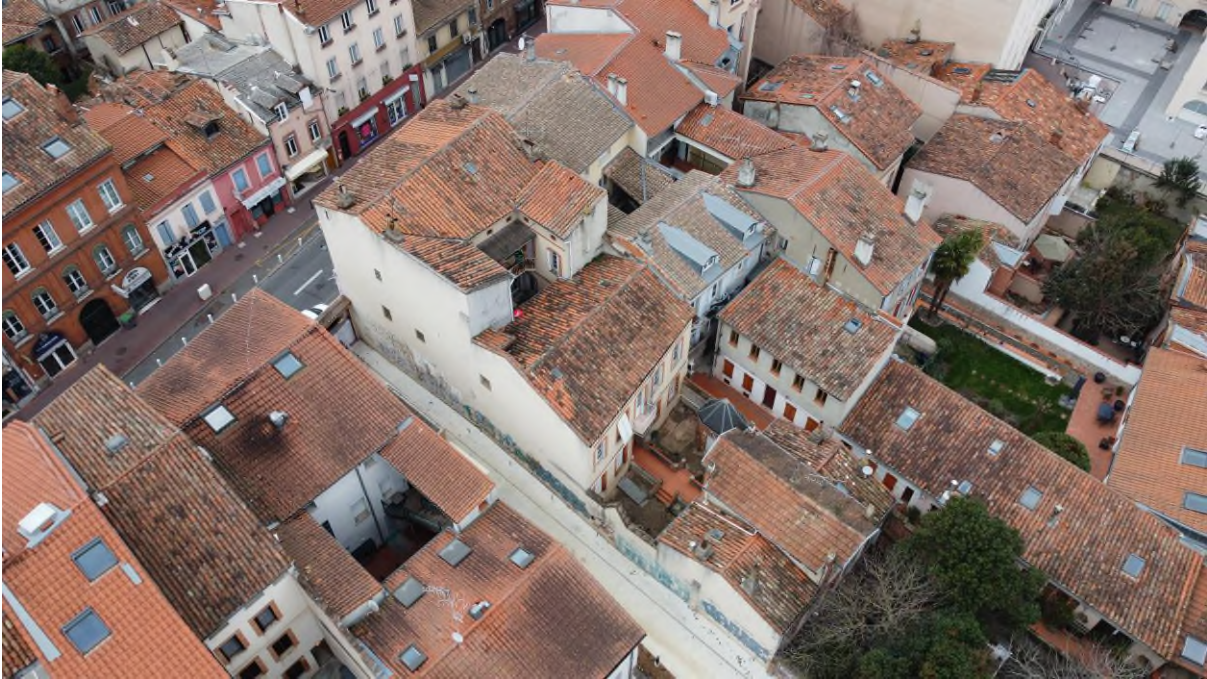
Photo aérienne du bâtiment existant et de ses alentours
