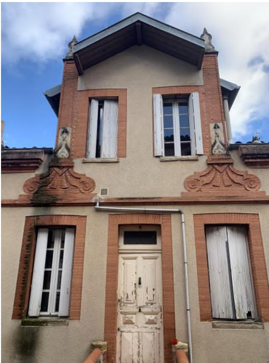
Photo de la chartreuse existante depuis la cour intermédiaire
