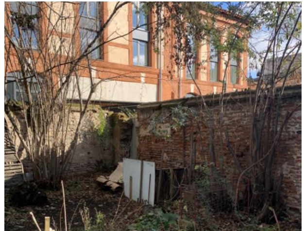
Photo existante des murets dans l'espace vert de la chartreuse
