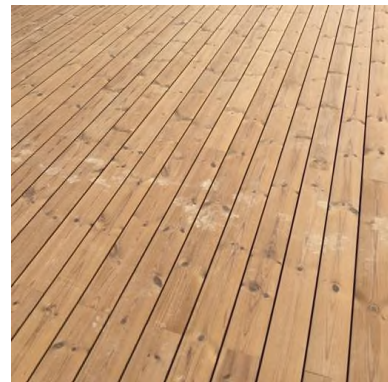
Terrasse platelage bois
