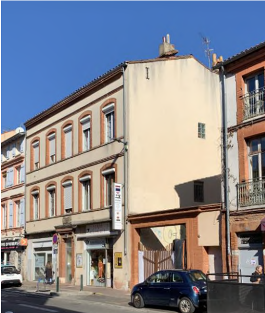
Photo du bâtiment existant sur la grande rue Saint Michel
