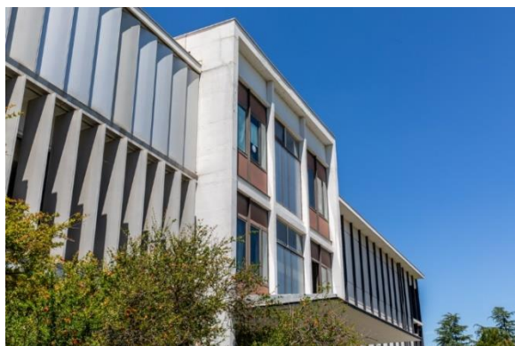
Photo 1 - Bâtiment 2A - FSI - Rangueil
