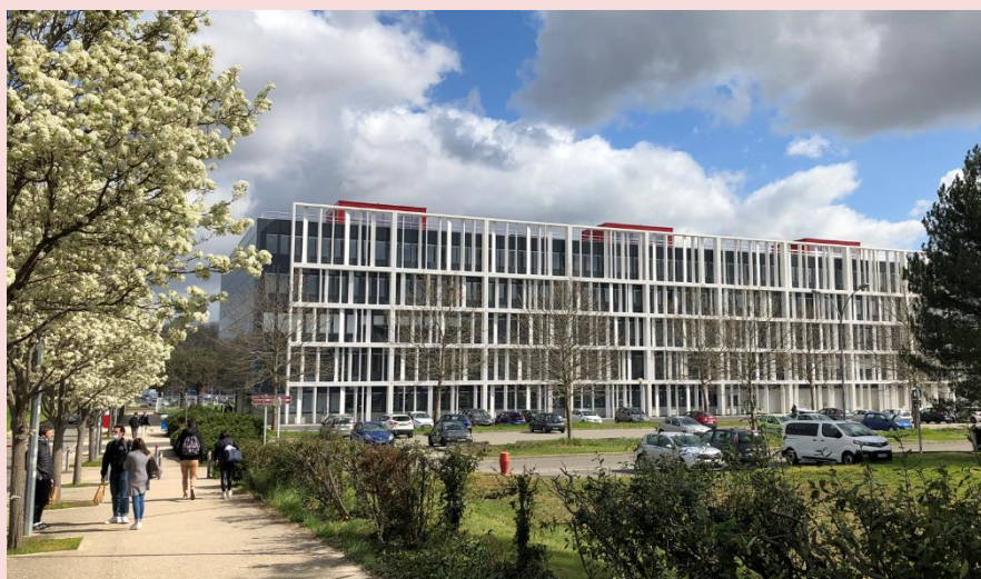
Photo 7 - Bâtiment U6 - FSI – Rangueil
