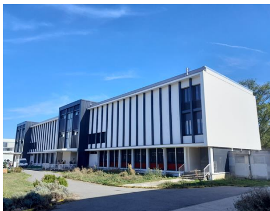
Photo 12 - Bâtiment 4A - FSI - Rangueil
