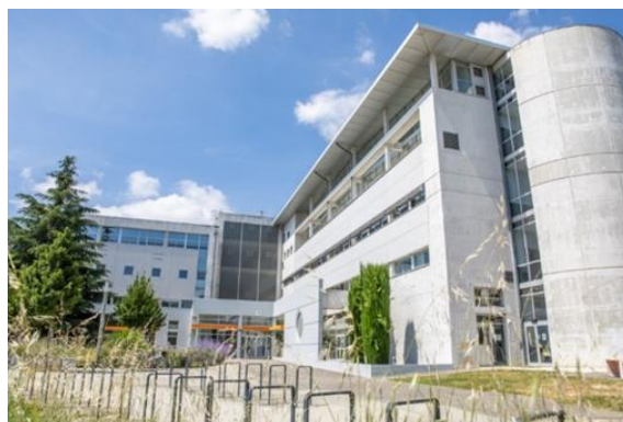
Photo 2 - Bâtiment U4 - FSI - Rangueil
