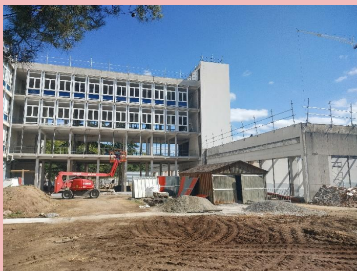
Photo 23 - Réhabilitation en cours du bâtiment Géotechnique - Rangueil
