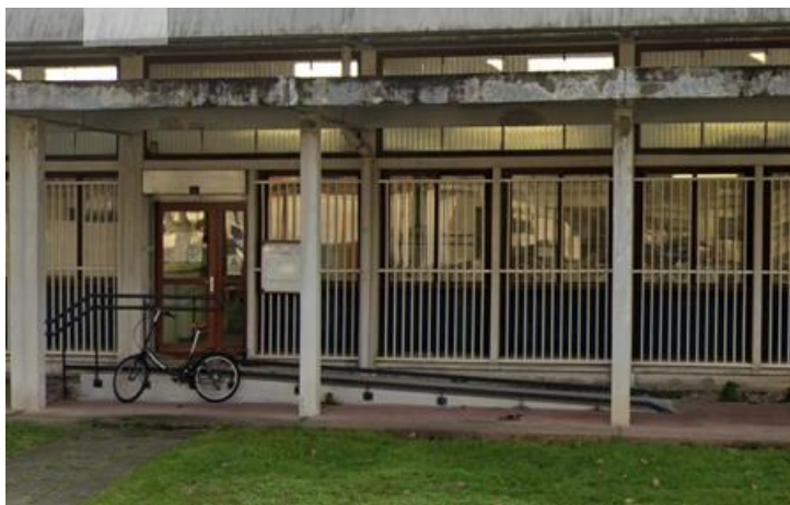
Photo 17 - Mise en accessibilité : rampe d'accès - bâtiment 2TP – FSI - Rangueil
