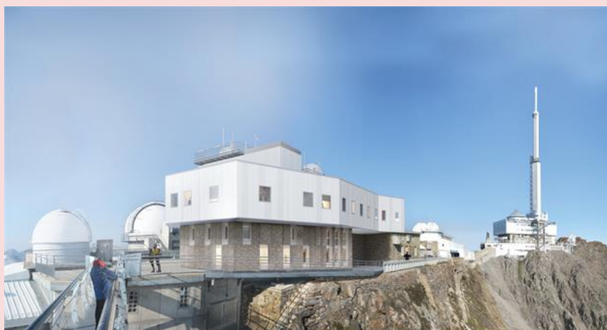
Photo 8 - Nouveau bâtiment Dauzère-Solère - OMP - Observatoire du Pic du Midi
