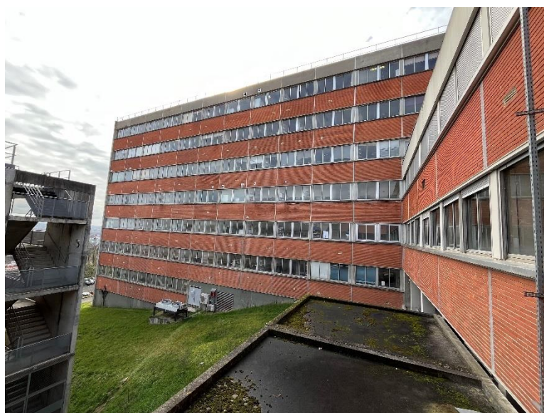
Photo 21 – Bâtiment L3 – Toulouse Rangueil CHU
