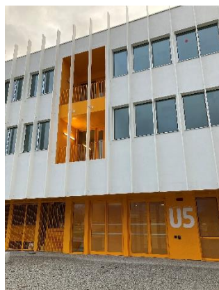
Photo 6 - Bâtiment U5 - Rangueil
