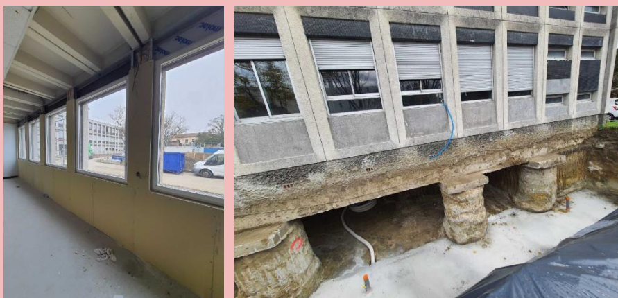
Photo 25 - Rénovation en cours des 2 bâtiments Mesure Physique – IUT - Ponsan
