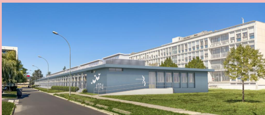
Image 24 – futur 4TP4 rénové – FSI – Rangueil
