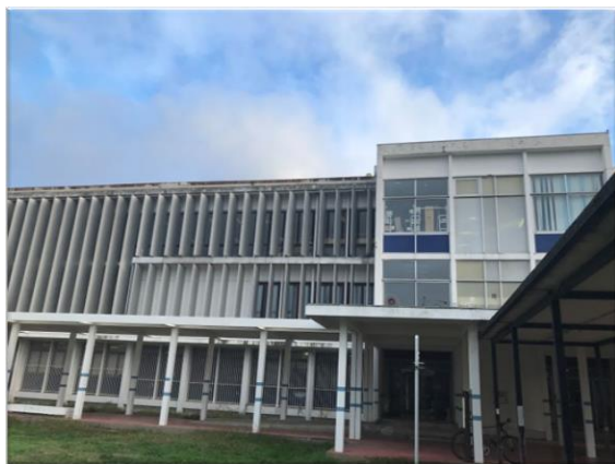
Photo 11 - Bâtiment 3A - FSI - Rangueil
