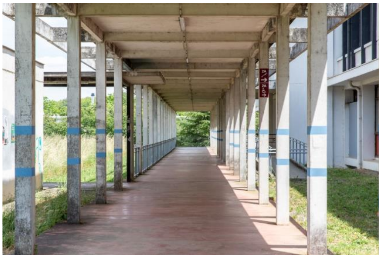
Photo 14 - Coursive extérieure permettant de circuler d'un bâtiment à l'autre - Rangueil
