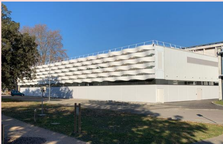
Photo 10 - Bâtiment 3R4 - Recherche - Rangueil
